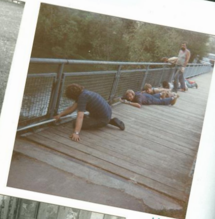
Kabelziehen am Steg
