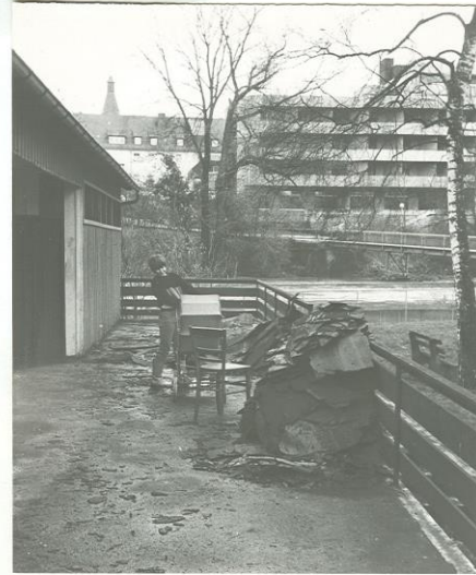
April 1983: Das Bootshaus be- kommt ein neues Dach
