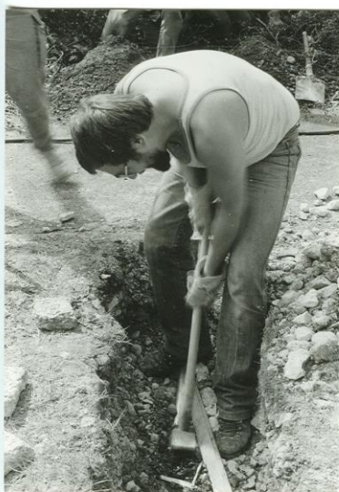
Durchstoßen eines Rohres unter dem Weg
